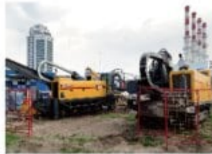
XZ680A水平定向钻机在俄罗斯施工 XZ680A HDD working in Russia
