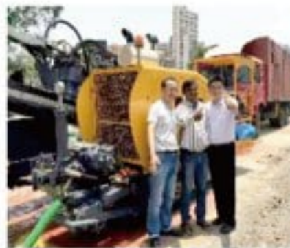
XZ200水平定向钻机在印度施工 XZ200 HDD working in India
