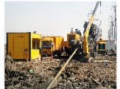
XZ3000水平定向钻机在武汉施工 XZ3000 HDD working in Wuhan
